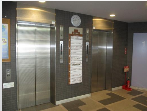
1階EVホール
